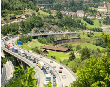
Autobahn bei Wassen
